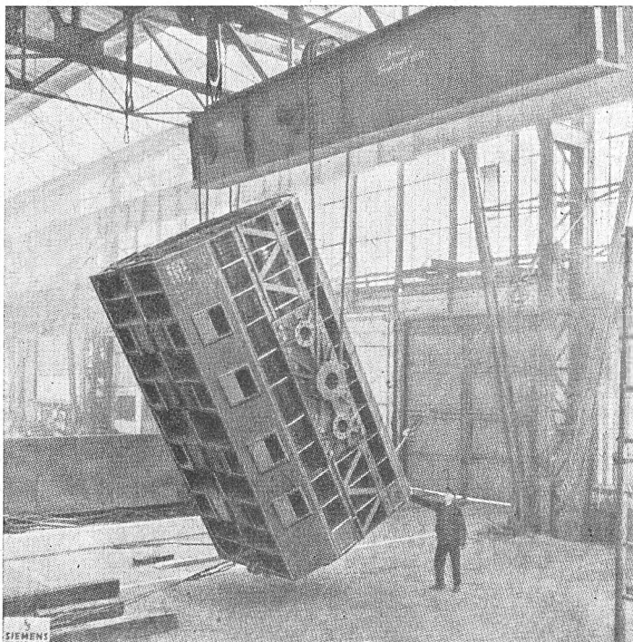
Rys. 30. Spakietowany stojan turbogeneratorsa na 80 000 kVA, 3000 obr./min. zawieszony na suwnicy
