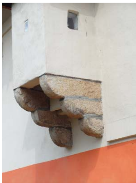
6. Wykusz w elewacji południowej młyna (fot. Rafał Eysymontt, 2016)
