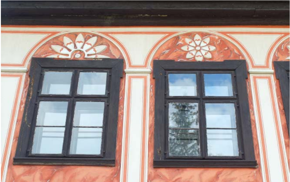
19. Okna w drugiej kondygnacji młyna (fot. Rafał Eysymontt, 2016)
