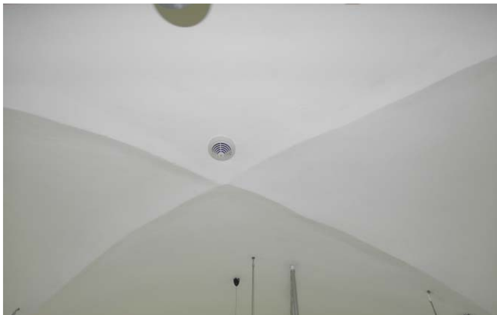
9. Sklepienie krzyżowe „z dzióbkami” w przyziemiu młyna (fot. Rafał Eysymontt, 2016)
