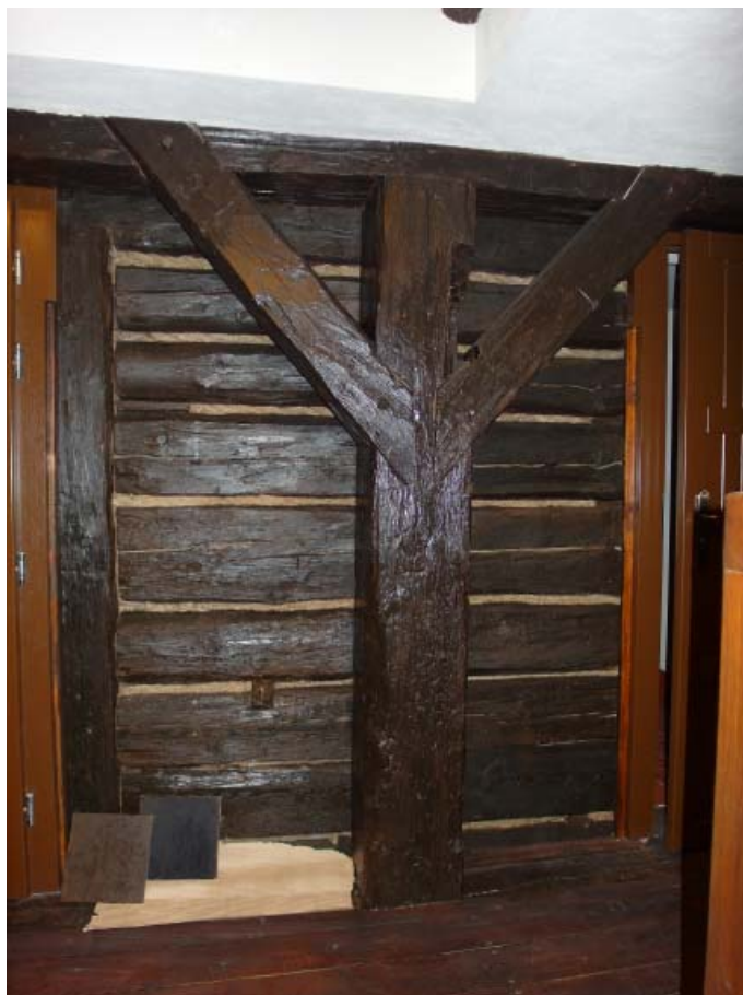
21. Konstrukcja wieńcowa najstarszej części suszarni (fot. Rafał Eysymontt, 2016)
