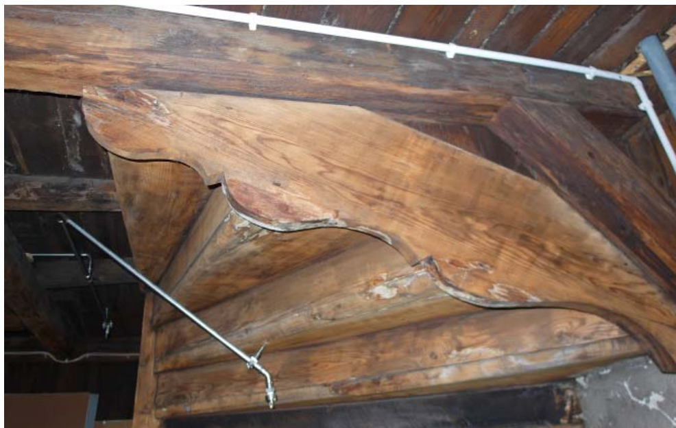
17. Wspornik schodów (fot. R. Eysymontt, 2016)
