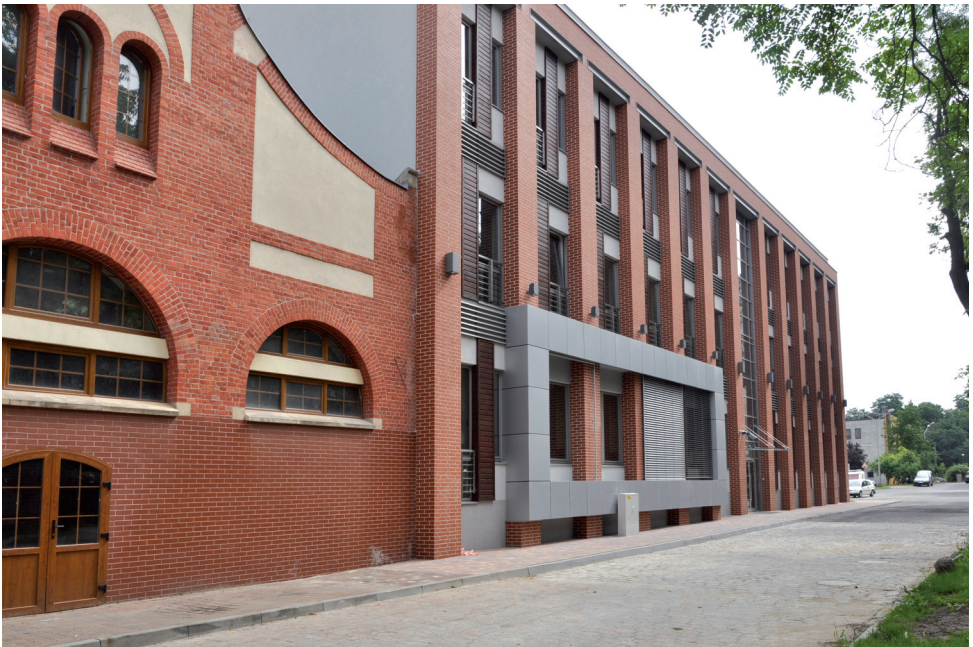
Fot. 7. Elewacja od południa
