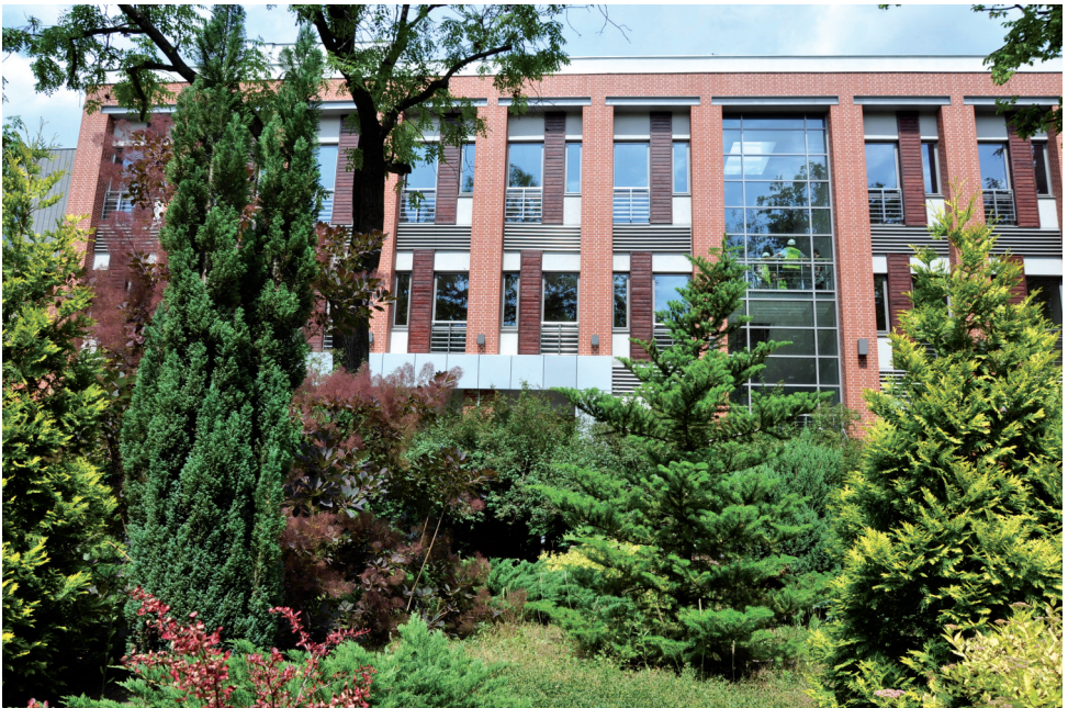
Fot. 8. Elewacja od południa
