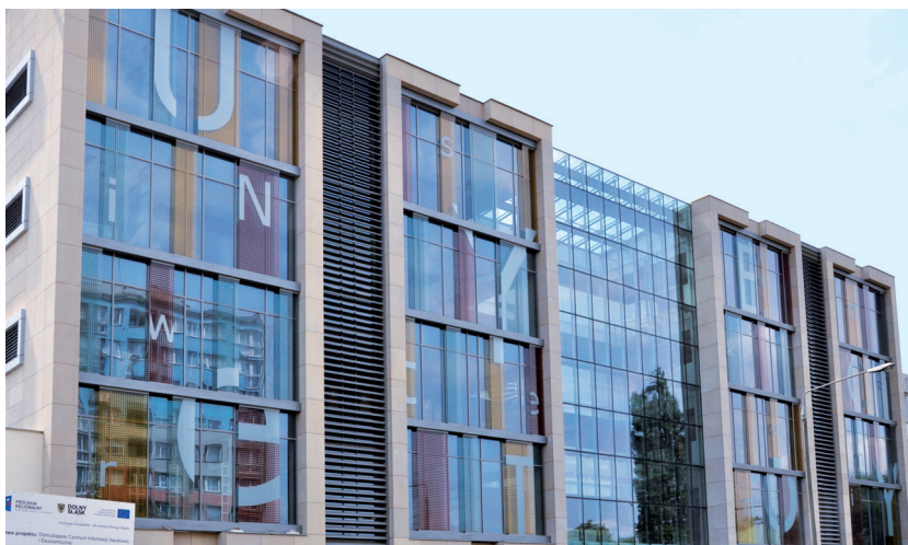
Fot. 20. Budynek A – 19 lipca 2011 roku
