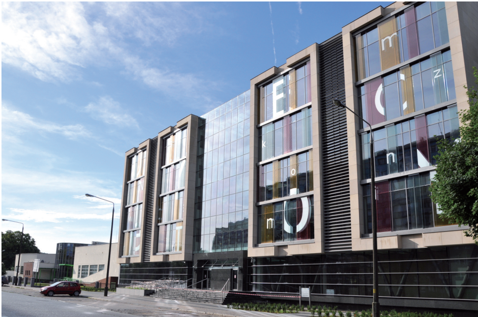
Fot. 6. Elewacja od ul. Wielkiej
