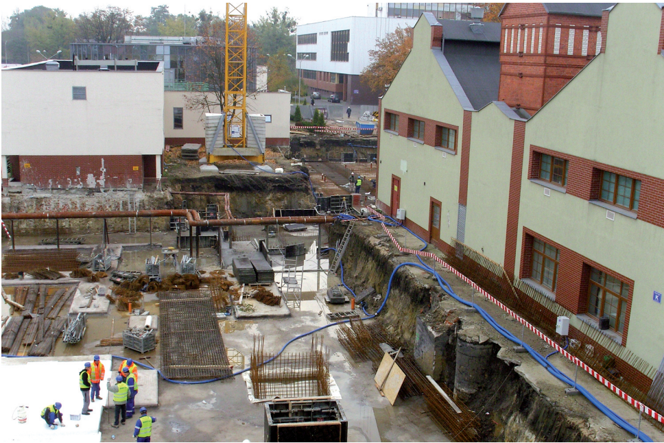
Fot. 3. Fundamenty (listopad 2009 r.)
