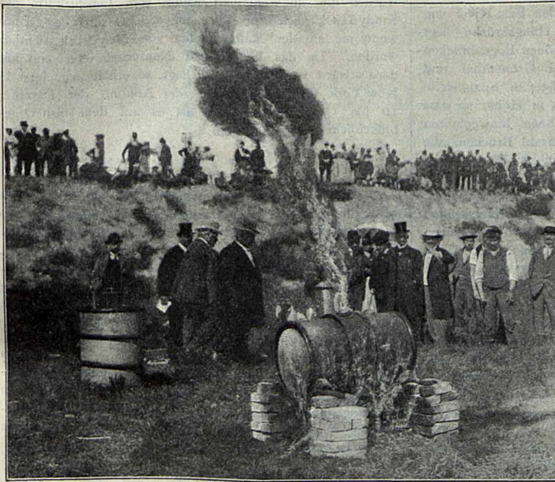
Explosionssichere Gefässe. Das in das Gefäss gefüllte Benzin explodirt nach dem Anzünden nicht, sondern vergast und verbrennt.
