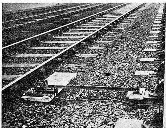
Rys. 2. Przyrząd do pomiaru bocznych przesunięć toru podczas przejeżdżania pociągu.
