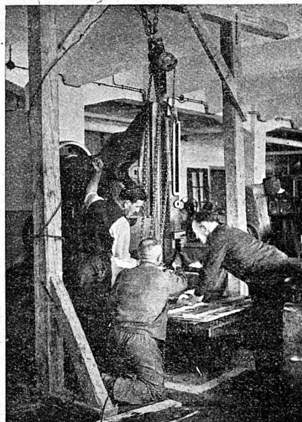
Fot. 2. Montaż dłutownicy po gruntownym remoncie.
