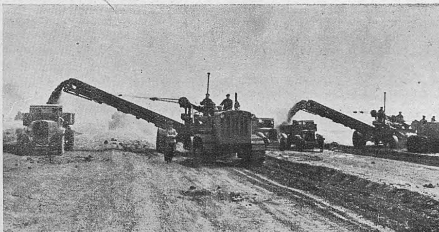
Rys. 1. Zastosowanie ciężkich ciągników gąsienicowych do wielkich robót ziemnych w Związku Radzieckim.
