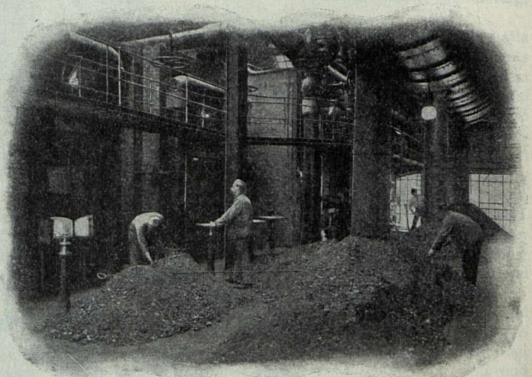
Kesselraum mit den Kohlenfallrohren.
