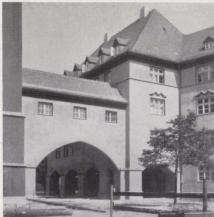
Polizeiamt Beuthen, Straßenüberbrückung. Siehe Seite 192 u. 193.
