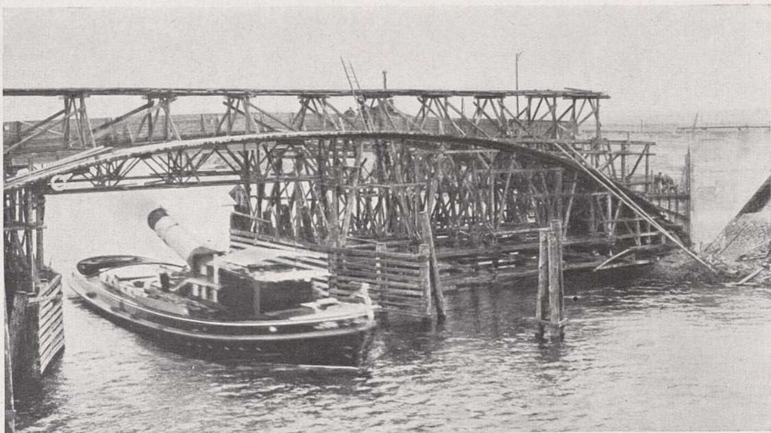
Abb. 59. Schiffsöffnungsöffnung im Lehrgerüst des wiesenseitigen Bogens. Beginn der Einschalung der Bogenstirnwände.
