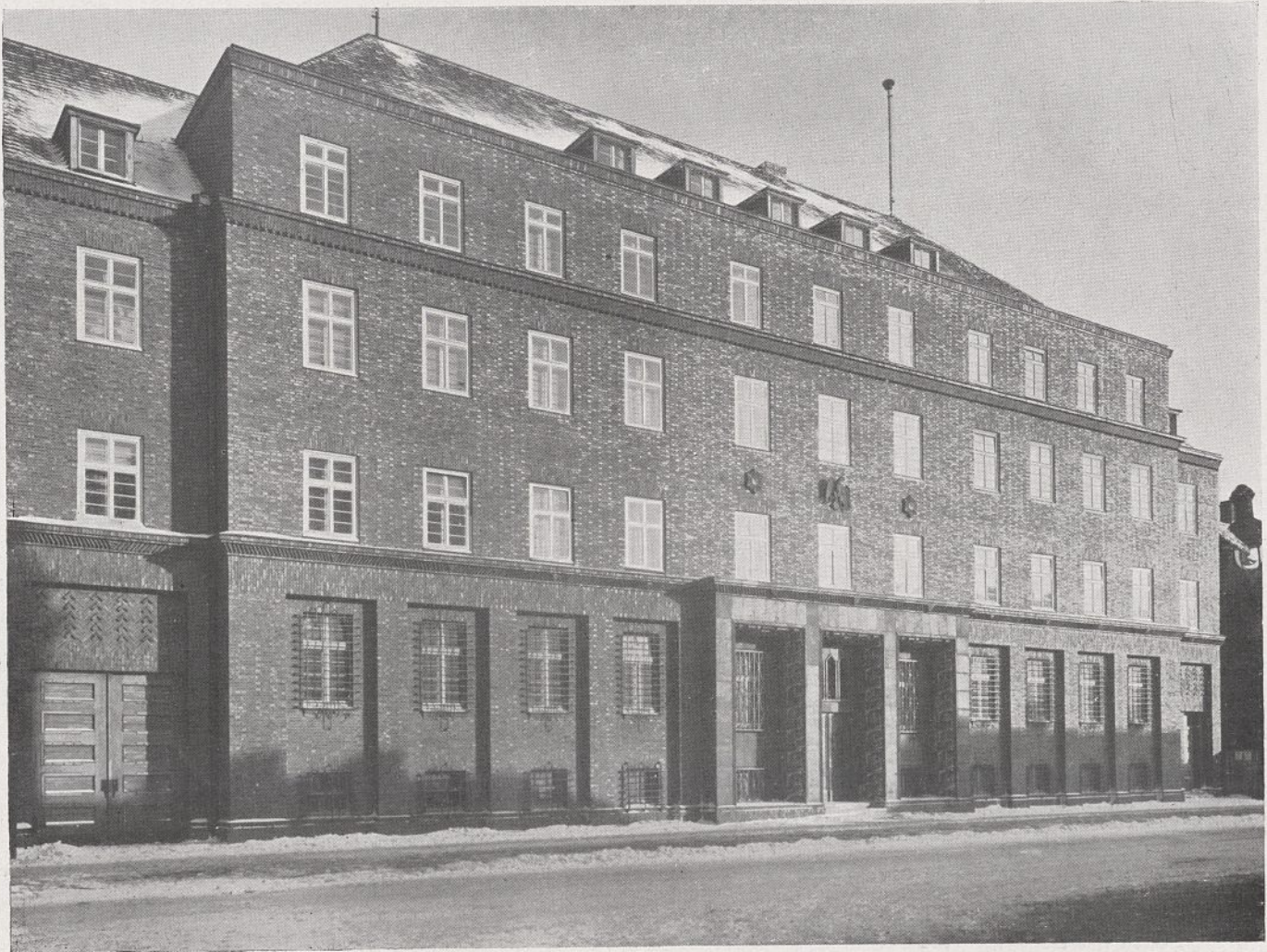
Ansicht von der Benninghoferstraße.
