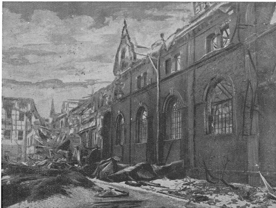
Widok na wschodnią ścianę maszynowni z zewnątrz; na tylnym planie gruzy po zburzonej nastawni
