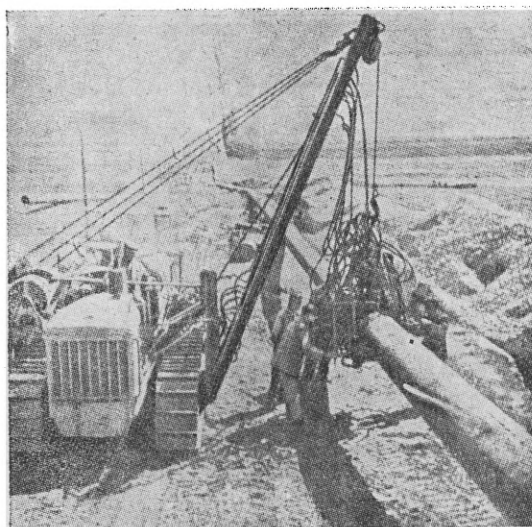
Rys. 6. Maszyna z rys. 5 zamontowana na ciągniku zaopatrzonym w żuraw, podczas wykonywania rurociągu dalekosiężnego na trasie Saratow — Moskwa.
