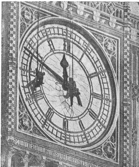
Rys. 1. „Big-Ben“ sławny zegar brytyjskiego parlamentu w Londynie, podczas gruntownego czyszczenia. O ogromie zegara świadczą „zegarmistrze“ oczyszczający tarczę.
