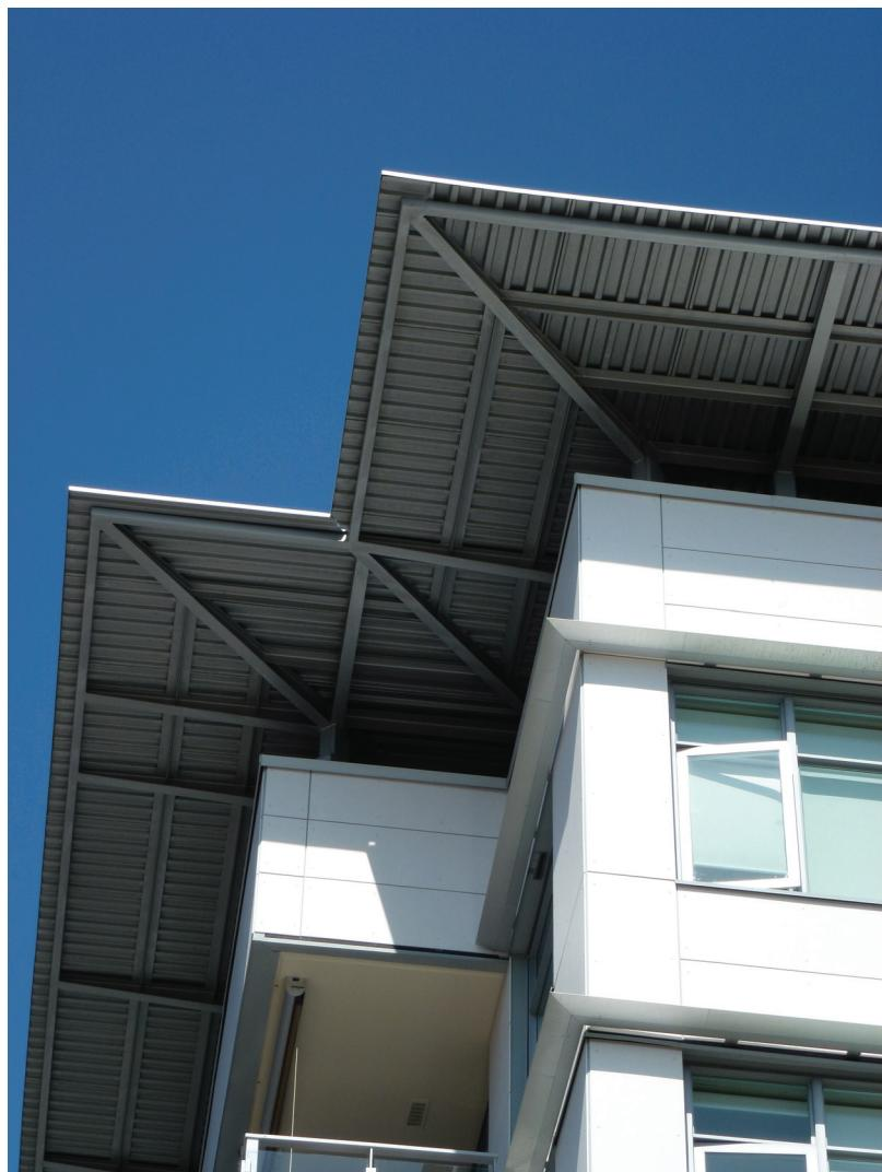
Łapacz deszczu na budynku wielorodzinny w wiosce olimpijskiej w Vancouver w Kanadzie. Wystająca poza budynek konstrukcja ma za zadanie zebranie większej ilości wody, która następnie posłuży do zapełnienia ogrodów deszczowych i retencji (fot. A. Bać, 2011)
