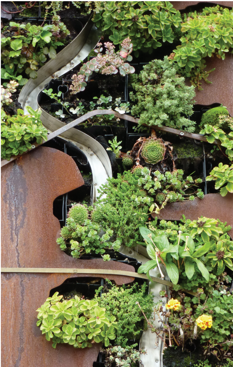
Fragment rury spustowej tworzącej kompozycję kanalików nawadniających zieloną ścianę. Obraz odzwierciedla zrównoważony system parków oraz rzek i kanałów spływających do oceanu w Toronto w Kanadzie (fot. A. Bać, 2011)
