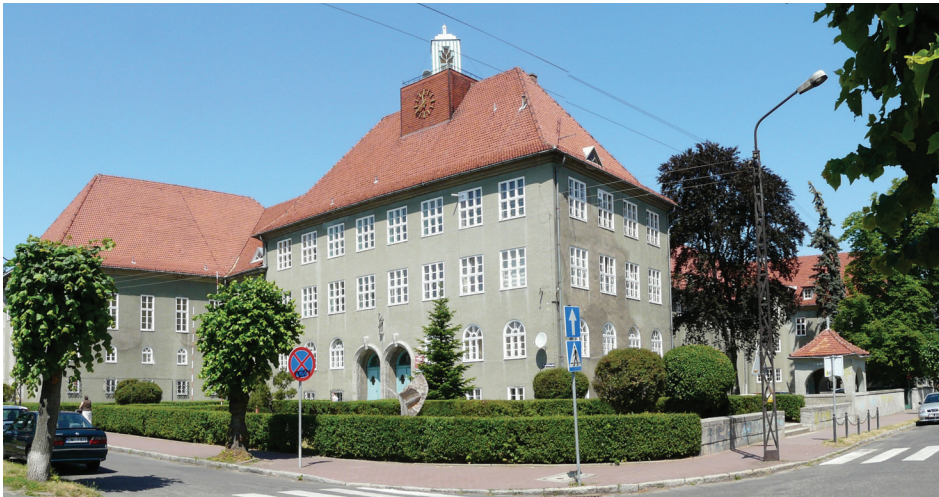
Il. 10. Budynek szkoły obecnie (fot. A. Lisowska)
