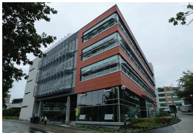
Il. 1. Widok na budynek CIRS z rogu West Mall i ul. Sustainability
