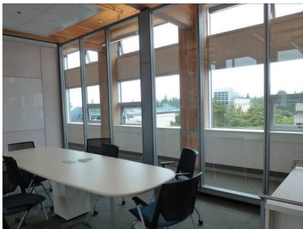
Il. 7. Pokój do pracy grupowej z widocznymi przeszkleniami od strony korytarza umożliwiającymi doświetlenie pomieszczeń światłem dziennym
