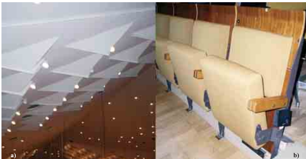
Il. 6. Detale sali głównej: a) ustrój akustyczny sufitu nad widownią, b) fotele Fig. 6. Main hall's details: a) acoustic structure above the audience, b) chairs
