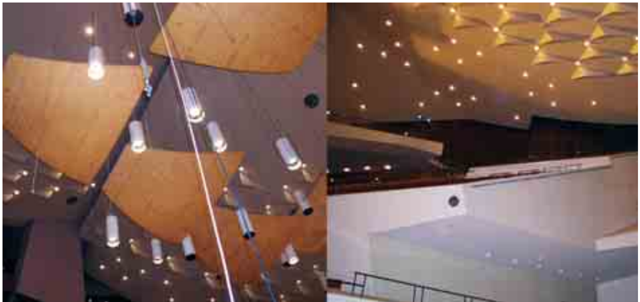
Il. 8. Wnętrze sali głównej: a) ustrój akustyczny nad sceną, b) ukształtowanie górnych tarasów Fig. 8. Interior of the main hall: a) acoustic structure above the scene, b) upper terraces formation
