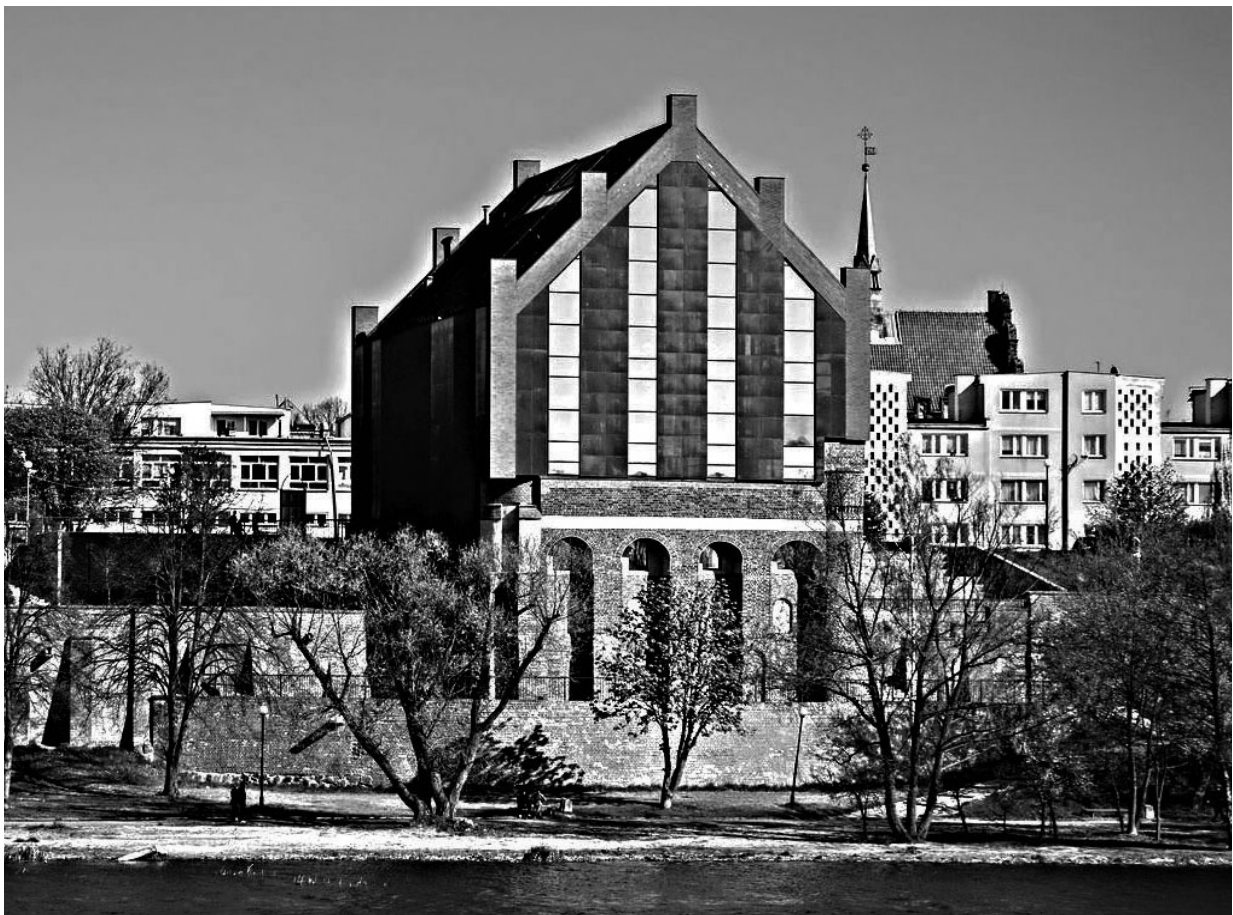
Il. 3. Widok po odbudowie (fot. J. Albrecht)
