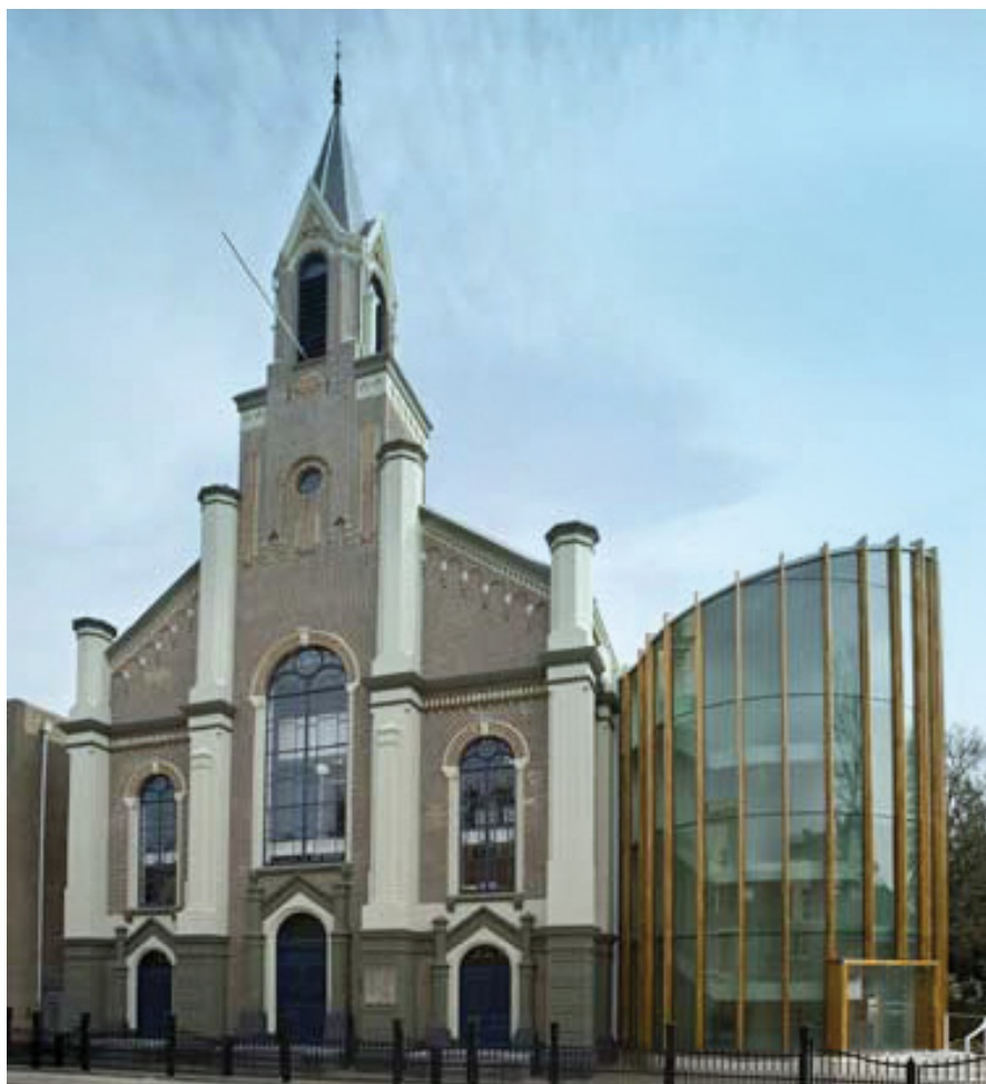
Il. 6. Widok na elewację frontową wraz z dobudowanym wejściem. Stan w 2007 r. [22]
