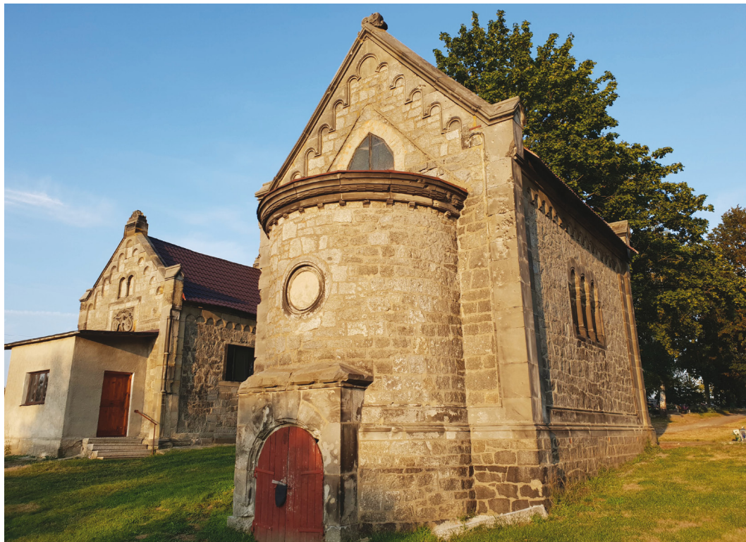
Il. 10. Współczesny widok zespołu w Rękowie od strony południowo-zachodniej. W mauzoleum rodu von Harach widoczne są ślady dawnego dachu nad absydą oraz zaślepią rozetą. W tle mauzoleum rodu von Mutius. Stan w 2018 r. (fot. S. Wróblewski)
