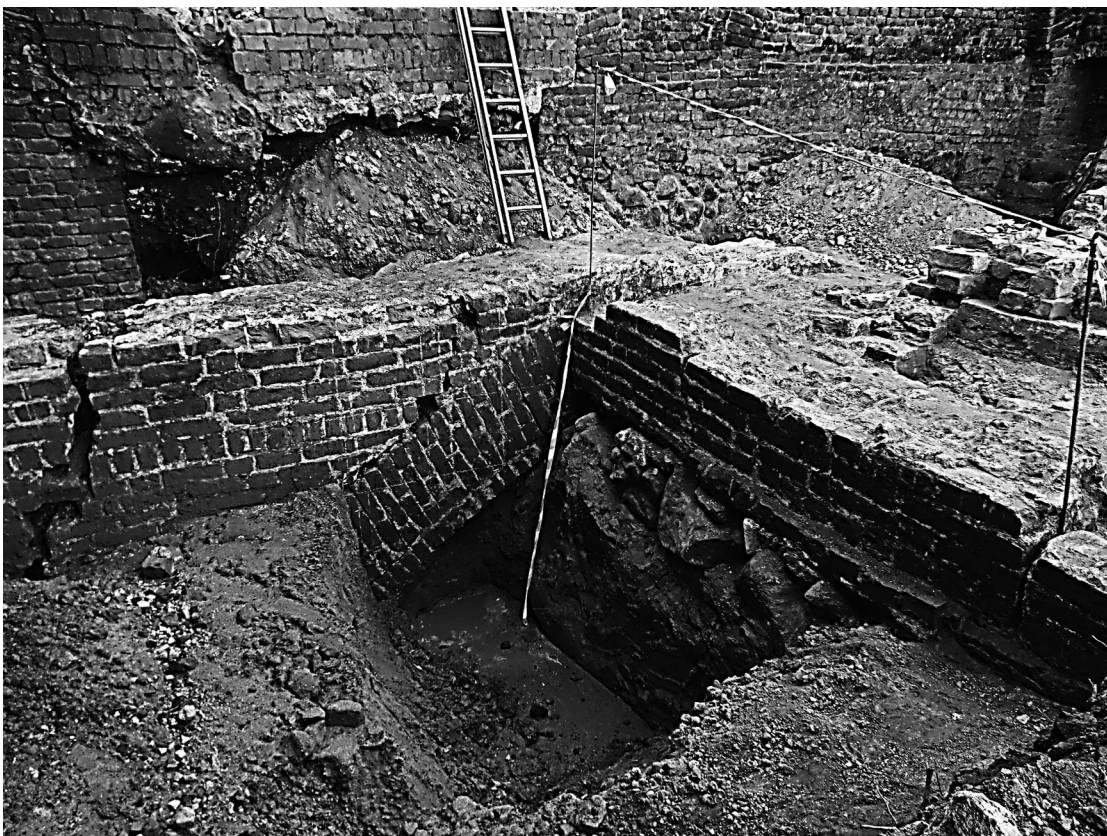
Il. 10. Południowy fundament łukowy (fot. J. Albrecht)
