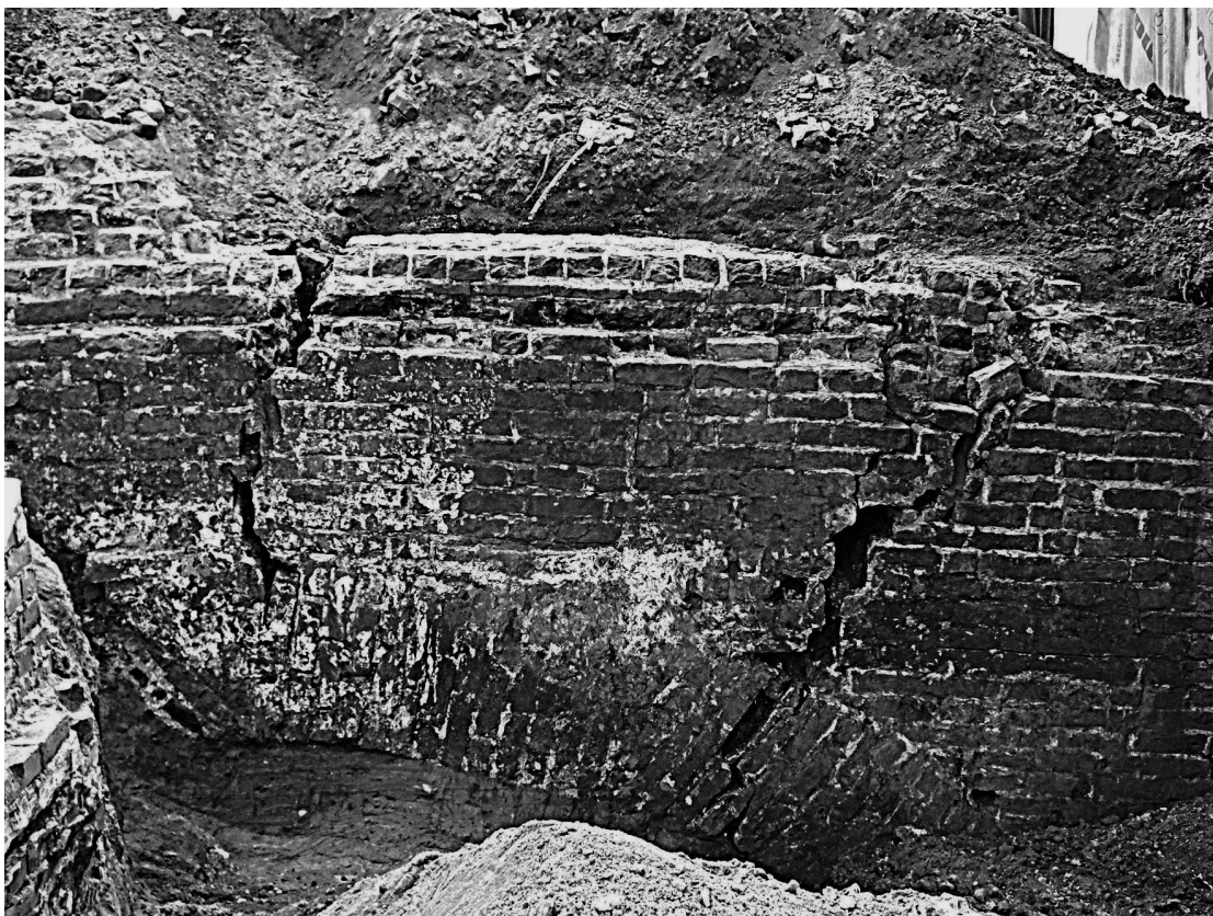
Il. 9. Północny fundament łukowy (fot. J. Albrecht)
