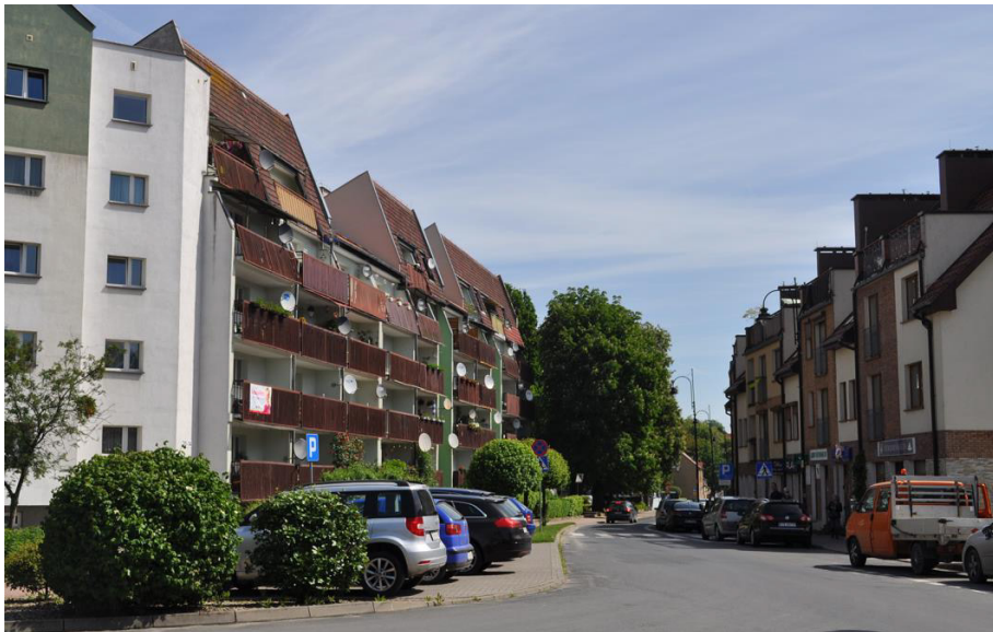
Rys. A 3.4. Trzebnica. Modernistyczna zabudowa mieszkaniowa na początku lat dwutysięcznych (na górze) i w 2019 r. (na dole)
