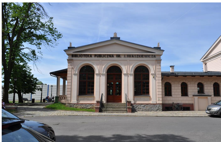
Rys. A 3.40. Oborniki Śląskie. Fragment budynku dworca kolejowego na początku lat dwutysięcznych (na górze) i w 2019 r. (na dole). Obecnie biblioteka publiczna
