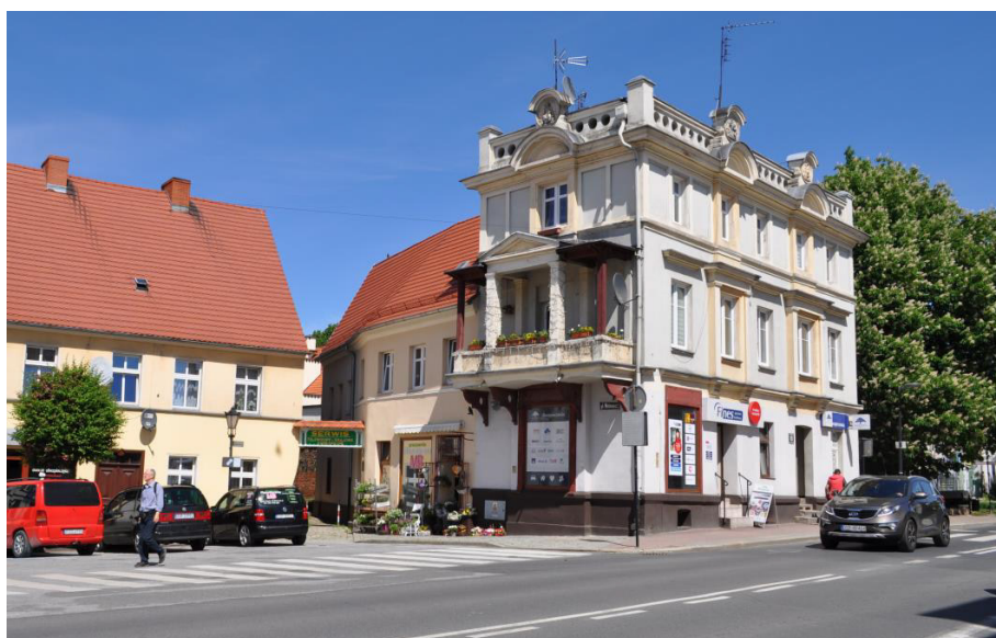
Rys. A 3.33. Środa Śląska. Kamienica we wschodniej pierzei rynku na początku lat dwutysięcznych (na górze) i w 2019 r. (na dole)
