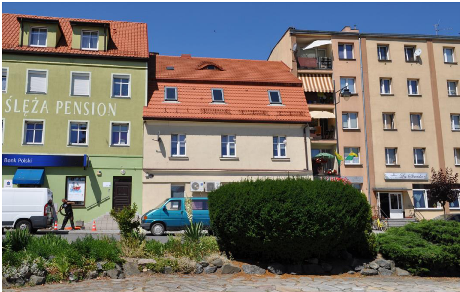
Rys. A 3.48. Sobótka. Sąsiedztwo starej i nowej zabudowy rynku na początku lat dwutysięcznych (na górze) i w 2019 r. (na dole)
