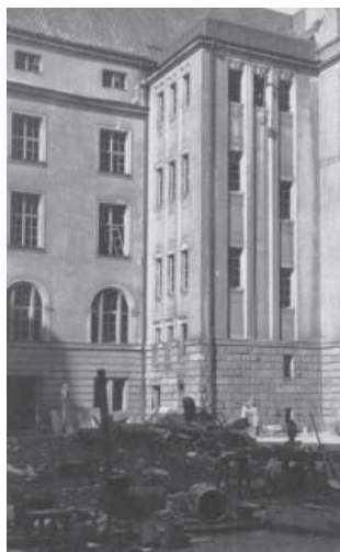
Budynek A-1 od strony wejścia do pomieszczeń Straży Akademickiej Politechniki (dawna Schulgasse)
