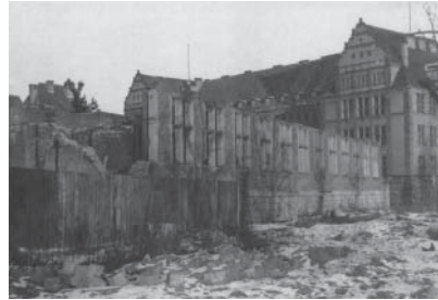
Zniszczony gmach Nowej Chemii (A-2) od strony Wybrzeża Wyspiańskiego (dawna Uferzeile)
