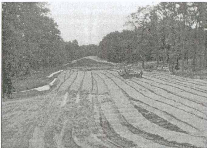
Prace przy usuwaniu wyrwy popowodziowej.
