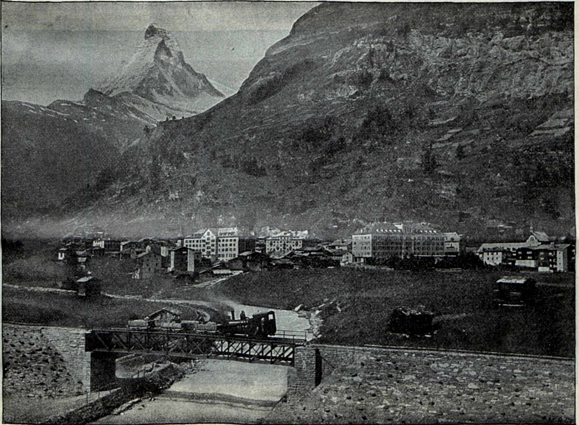
Ansicht von Zermatt. — Baulocomotive mit Materialzug auf der Vispbrücke.
