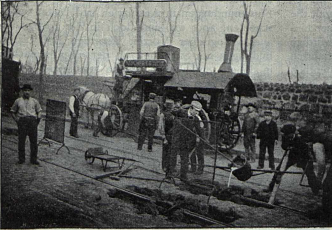
Das Umgiessen eines Schienenstosses.
