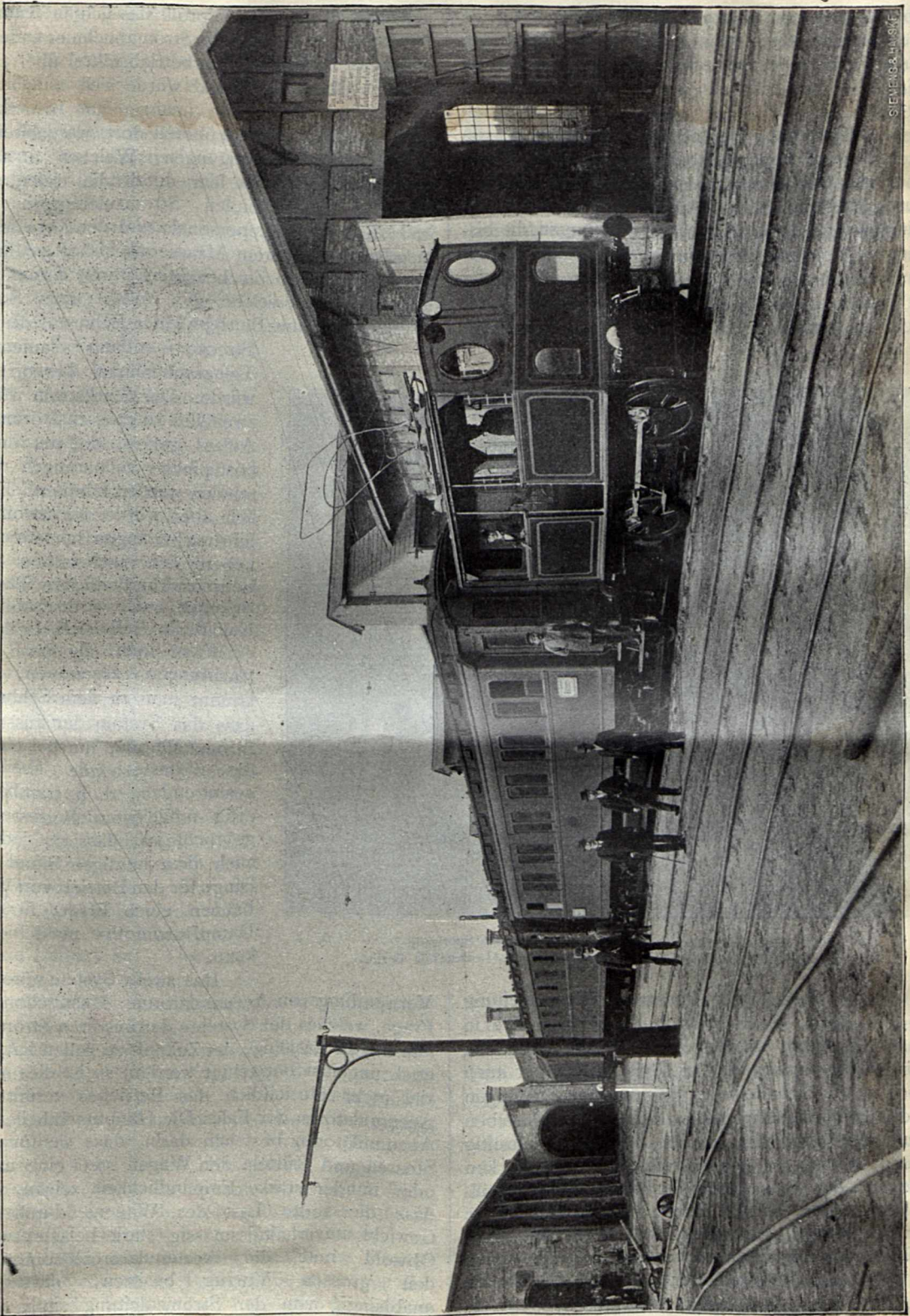
Elektrische Locomotive für den Verschiebedienst bei der Königlichen Eisenbahn-Reparatur-Werkstätte zu Potsdam, gebaut von der Firma Siemens & Halske in Berlin.
