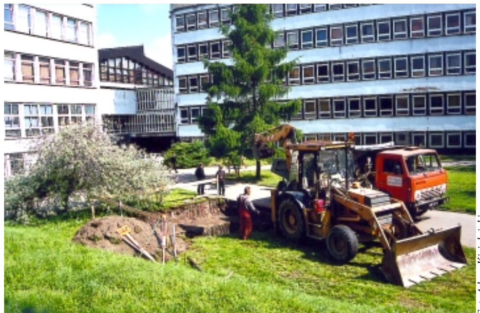
16.05.2001 r. godz. 10.00. Prace trwają. Wykop prawie gotowy.
