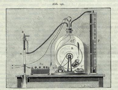
REGNARDS Versuch über die Ursachen der Bergkrankheit. C2 Glocke der Luftpumpe. CC' die beiden Meerschweinchen. R Tretrad, welches ein Elektromotor M in Bewegung erhält. Re Rheostat für die Stromregulirung. TE Wasserstrahl-Luftpumpe. P Manometer.
